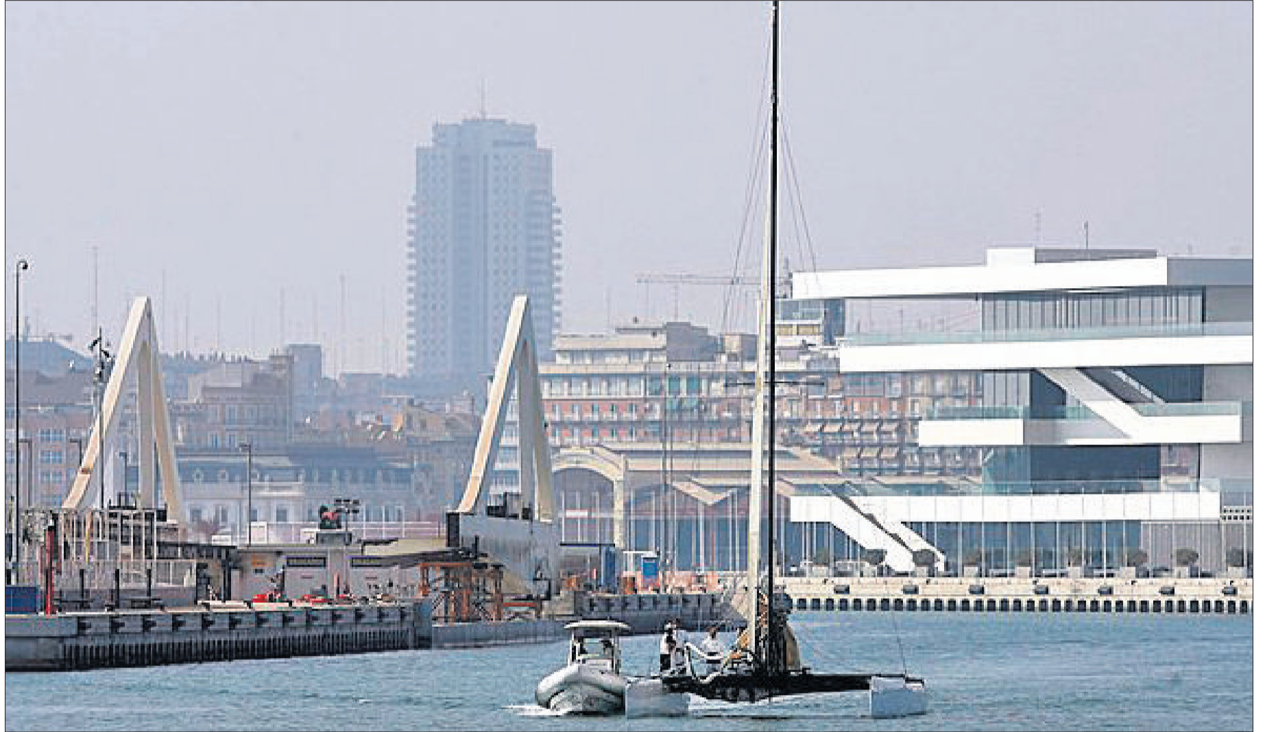
Valence. Verra-t-on bientôt des multicoques géants dans le port construit pour accueillir l'America's Cup en 2007? (KEystone)
